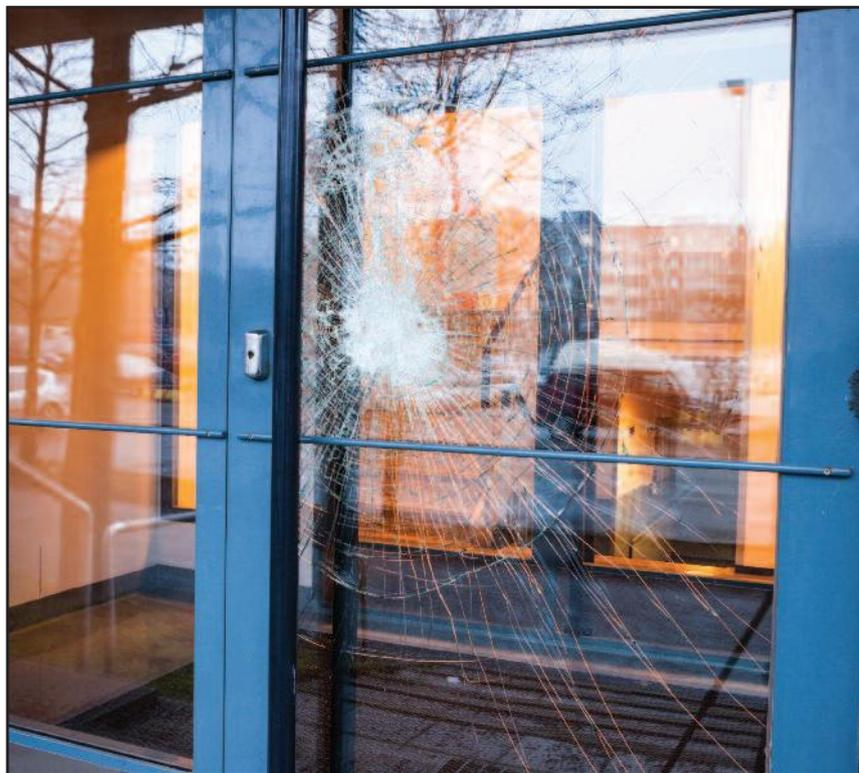
di vetro piano con interposti uno o più strati di materia plastica, incollati tra loro per l'intera superficie; è un vetro di sicurezza, con comportamento a rottura molto buono, anche perché i frammenti di vetro rimangono attaccati agli strati interposti di materia plastica (i vetri antisfondamento e antiproiettile sono una particolare categoria di vetro stratificato).
